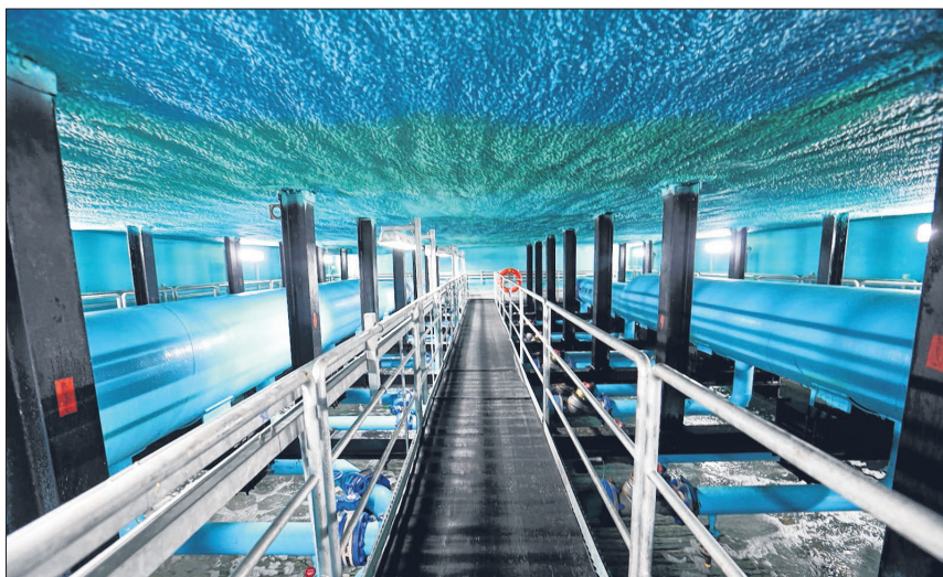
制冷厂中的结冰室内储存着大量冰水，员工可在电价上涨或出现停电等状况时，直接融化冰水制冷，无需启动制冷机。（林国明摄）
