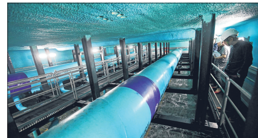
制冷厂中的结冰室内储存着大量冰水，员工可在电价上涨或出现停电等状况时，直接融化冰水制冷，无需启动制冷机。（林国明摄）
