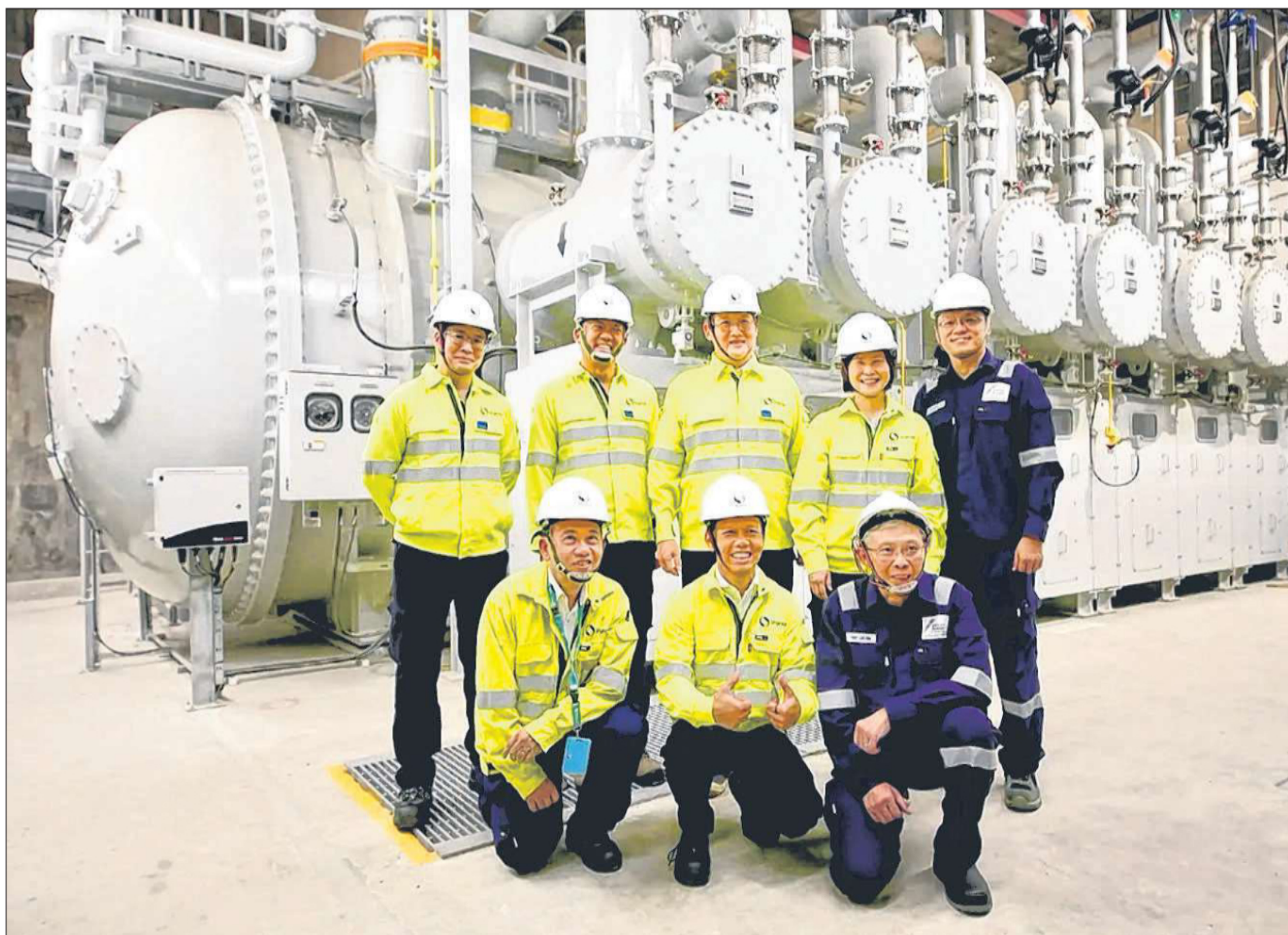
主管能源与科技事务的人力部长陈诗龙医生（后排左三）和外交部兼贸工部政务部长颜晓芳（后排右二），近日走访拉柏多地下变电站。
