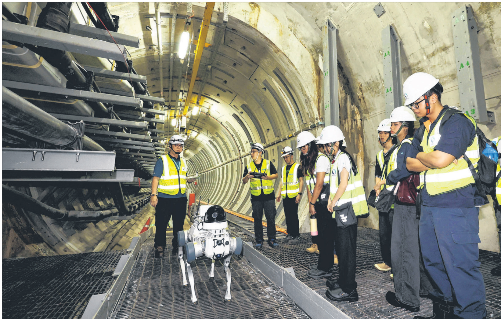
新能源技术员邓靖楷（46岁，左一）向获得新能源工程系助学金的工艺教育学院学生，介绍如何操作机器狗SPock，让它自主巡视电缆隧道，从而提升隧道维护工作的安全与效率。助学金得主之一的许志伟（右一）认真聆听讲解。（何家俊摄）
