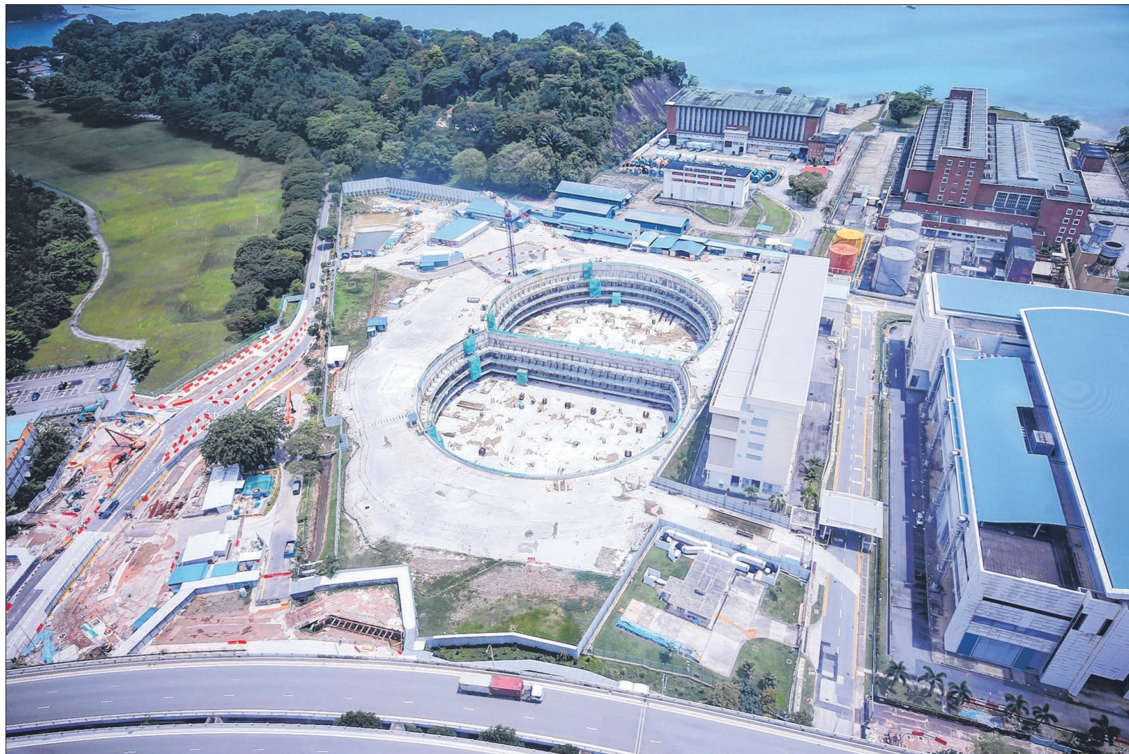
新加坡能源集团将在前巴西班让发电厂所在地兴建本地最大的地下变电站，工程预计2024年完工。（何家俊摄）
